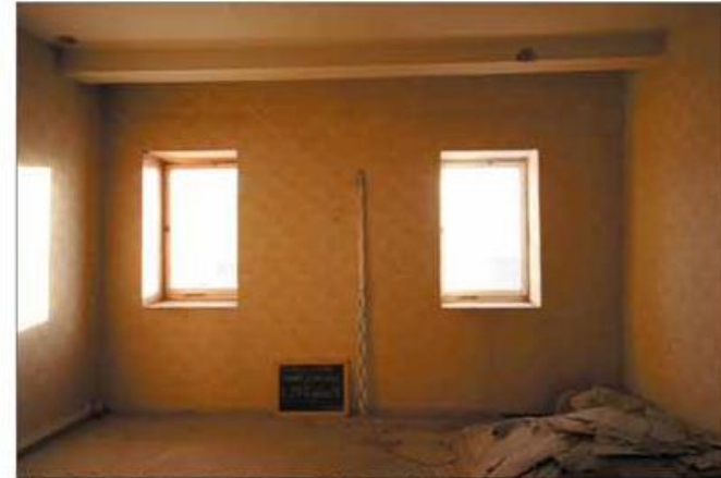
Blick nach Süden, Wand S mit den Fenstern 202S-F1 und 202S-F2. Scheinbar zeichnen sich über den Fenstern auch Bögen ab. Mögl. ehemalige Nischengliederung der Wand.
