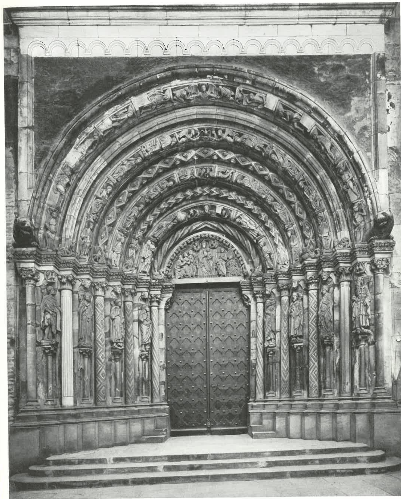
1 Freiberg, Dom. Goldene Pforte, Gesamtansicht.
